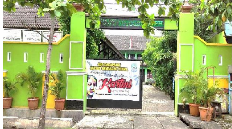
Gambar 2.3. Tampak Depan SDN Dadapsari
