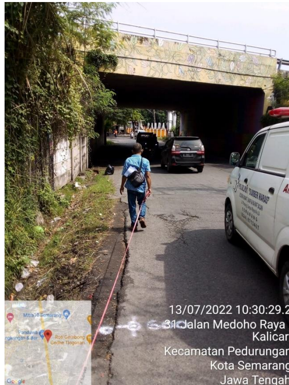
Gambar 3. 4 Eksisting 0% Jalan Medoho 1
