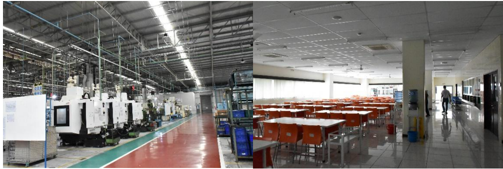
Gambar 2 Kondisi Bangunan PT. Kubota Indonesia (Sumber: Laporan Pemeriksaan Kelaikan Fungsi Bangunan Gedung PT. Kubota Indonesia, 2019)
