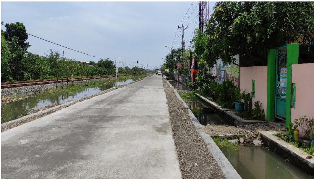
Gambar 5. 3 Kondisi Existing Saluran Drainase Jalan Muktiharjo Raya
