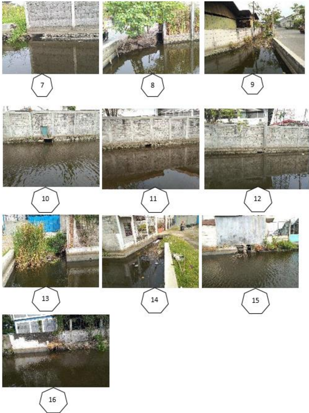
Gambar 4.3 Dokumentasi Survey Saluran Kelurahan Gebangsari.
