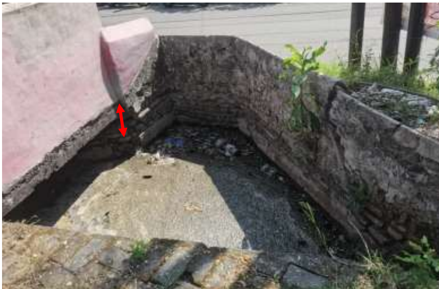
Gambar 4.3. Sedimen pada saluran drainase (Sumber : Dokumen CV. Mekar Konsultan, 2023)
