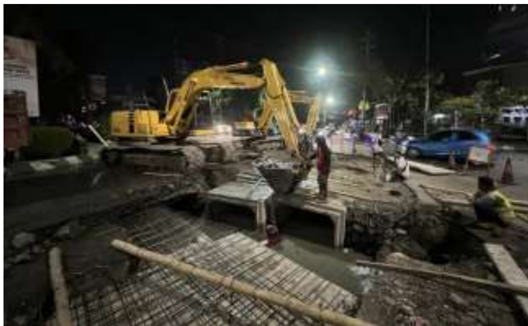
Gambar 4.16 Fabrikasi pada lokasi Box Culvert untuk menahan beban berat (Sumber : CV. Progresif Quality Planning, 2023)
