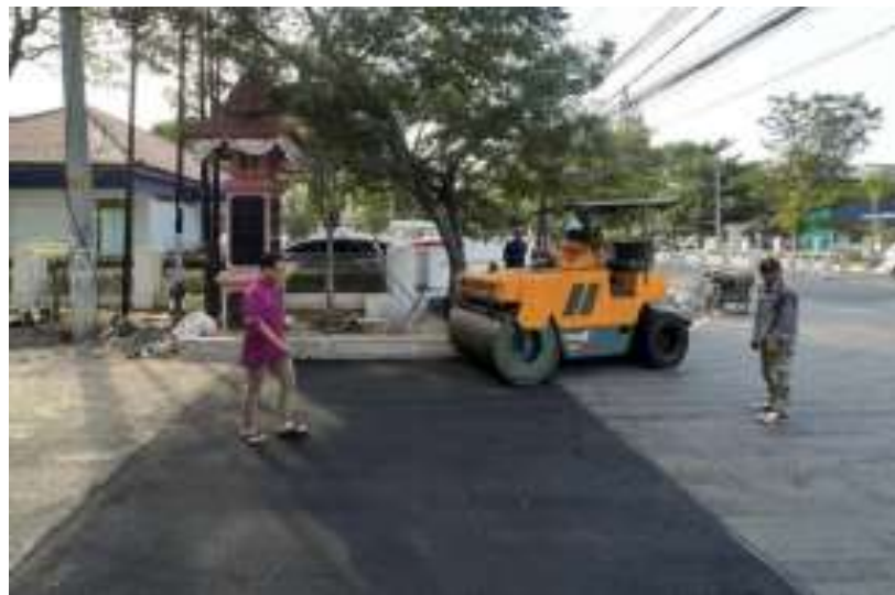
Gambar 4.18 Pengaspalan lapisan atas box-culvert (Sumber : CV. Progresif Quality Planning, 2023)
