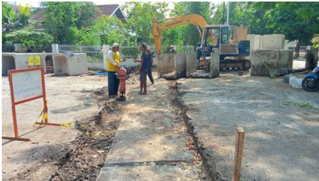
Gambar 4.15 Pemadatan tanah sekitar Box Culvert (Sumber : CV. Progresif Quality Planning, 2023)
