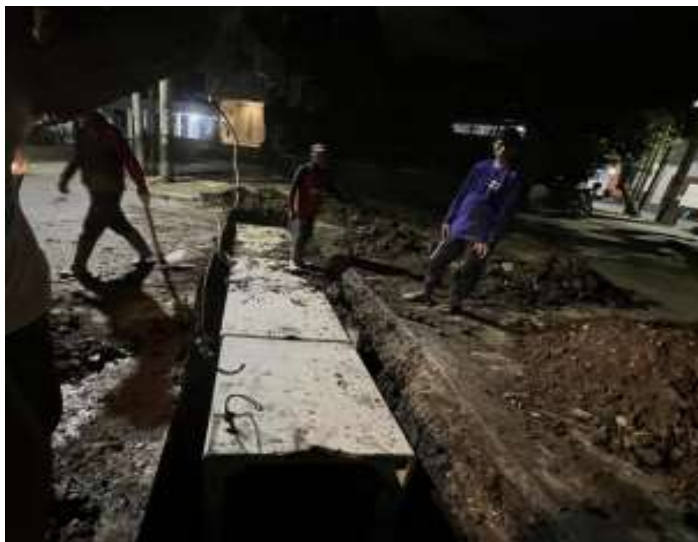
Gambar 4.13 Pemasangan Box Culvert (Sumber : CV. Progresif Quality Planning, 2023)
