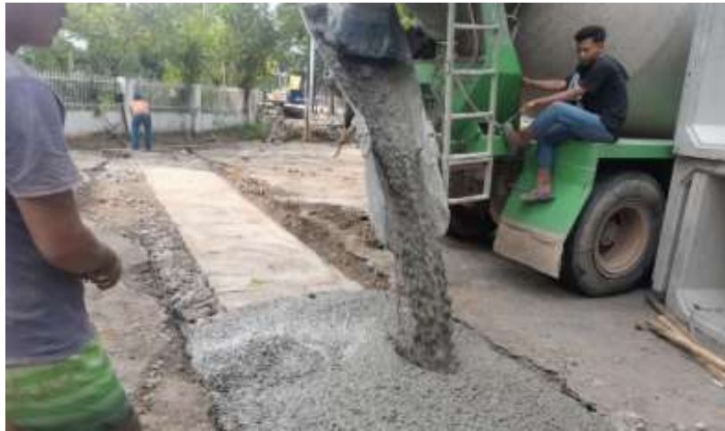
Gambar 4.17 Pengecoran lapisan atas Box Culvert (Sumber : CV. Progresif Quality Planning, 2023)
