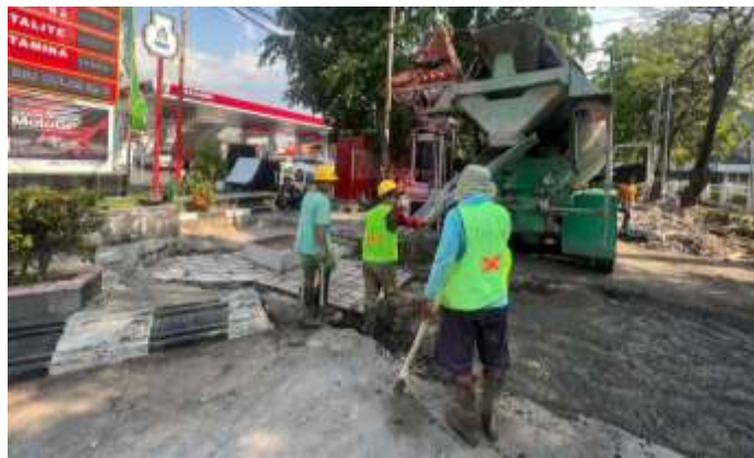
Gambar 4.20 Pekerja menggunakan APD (Sumber : CV. Progresif Quality Planning, 2023)
