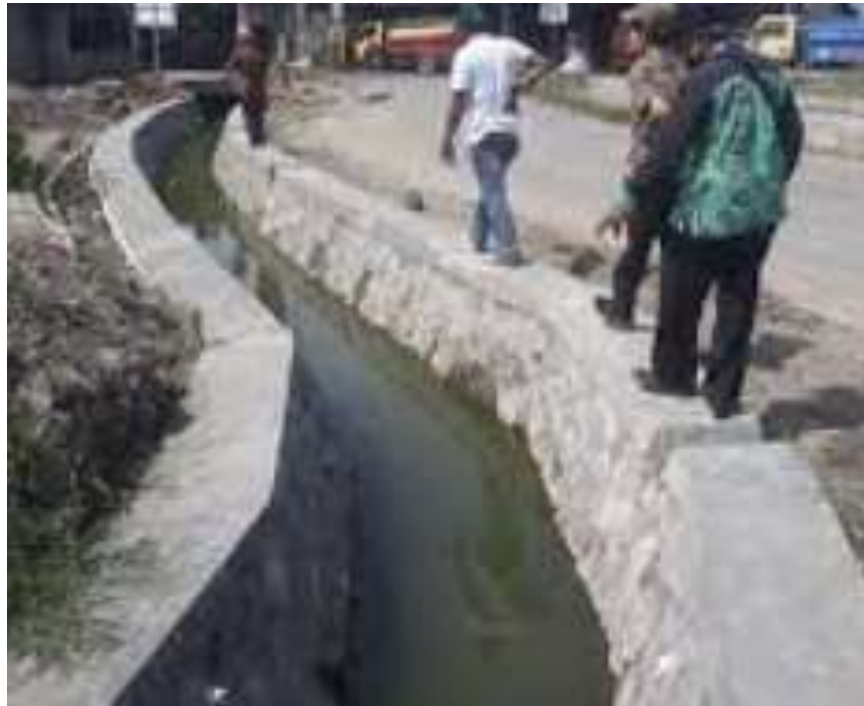
Gambar 2.4 Drainase Buatan (Sumber : Dokumentasi , 2023)
