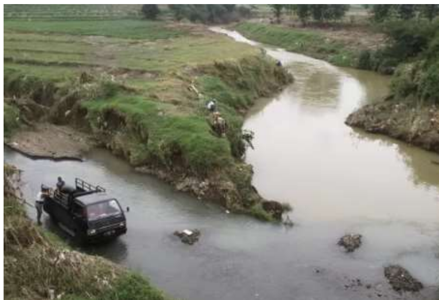
Gambar 2.3 Drainase Alami (Sumber : Dokumentasi, 2023)
