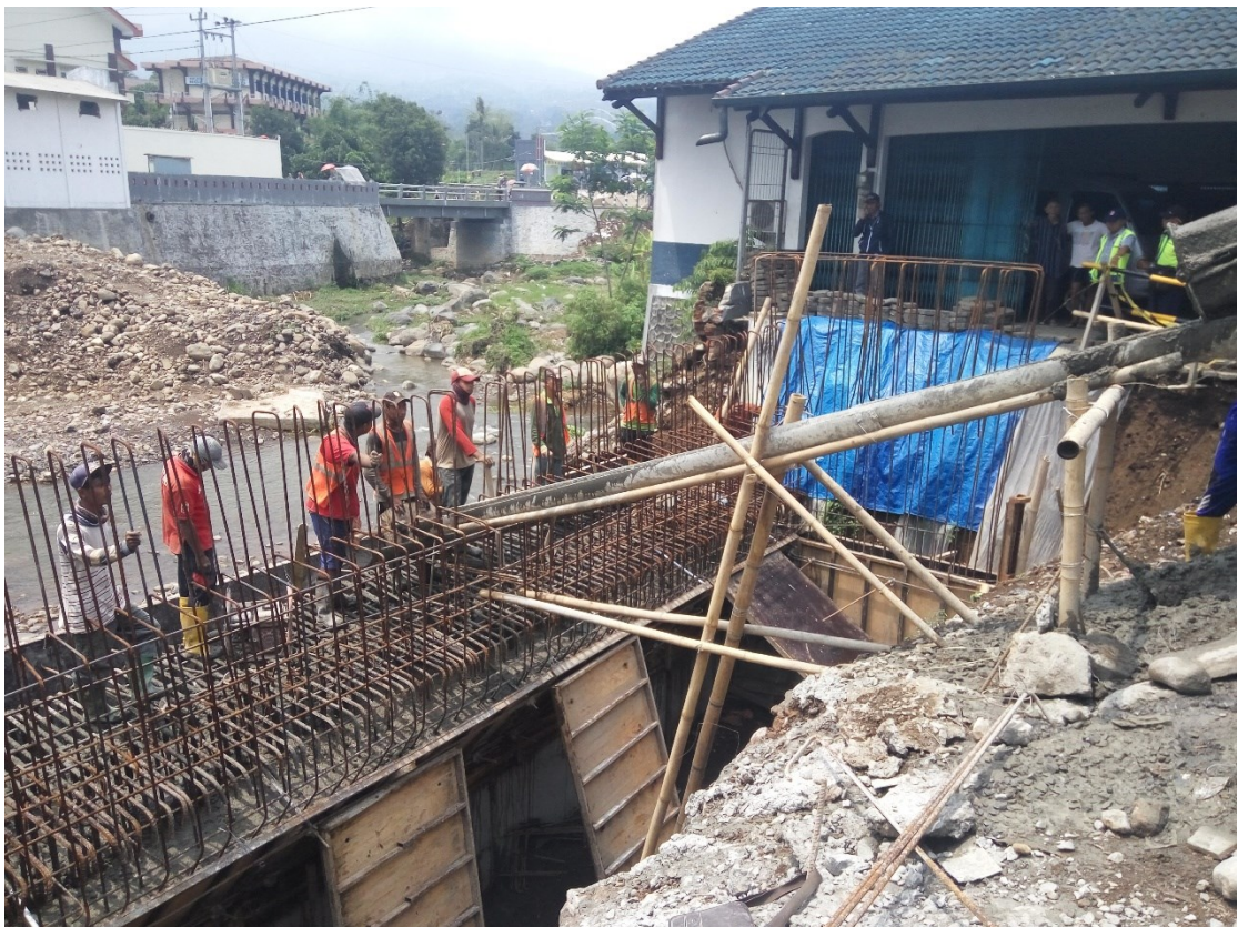
Gambar 2. Para pekerja pengecoran yang sudah mengenakan APD saat bekerja
