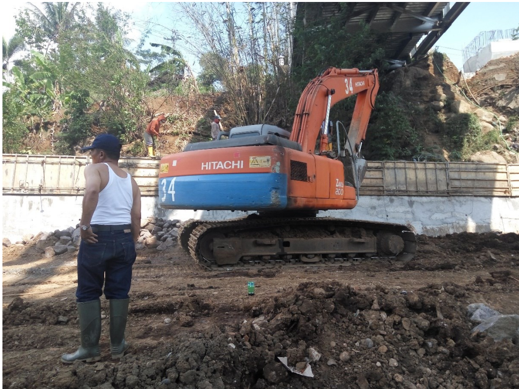
Gambar 4. Karyawan yang tidak mengenakan APD secara layak dan benar saat bekerja di dekat mesin
