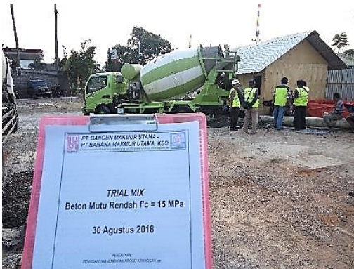
Gambar 9. Kegiatan trial mix campuran beton di batching plant penyedia jasa, Kab Temanggung
