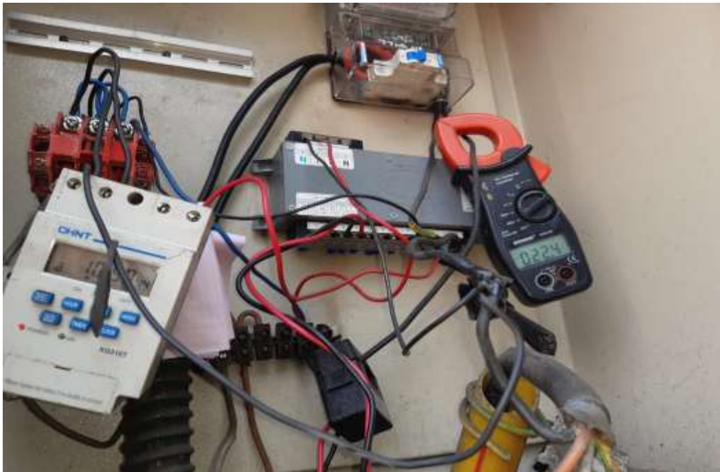
Gambar 3.7 Pengukuran beban daya terpakai di Jl.Dr.Wahidin
