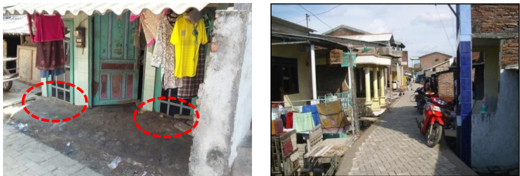
Gambar 4.3. Kondisi Bangunan, Jalan Lingkungan dan Drainase
