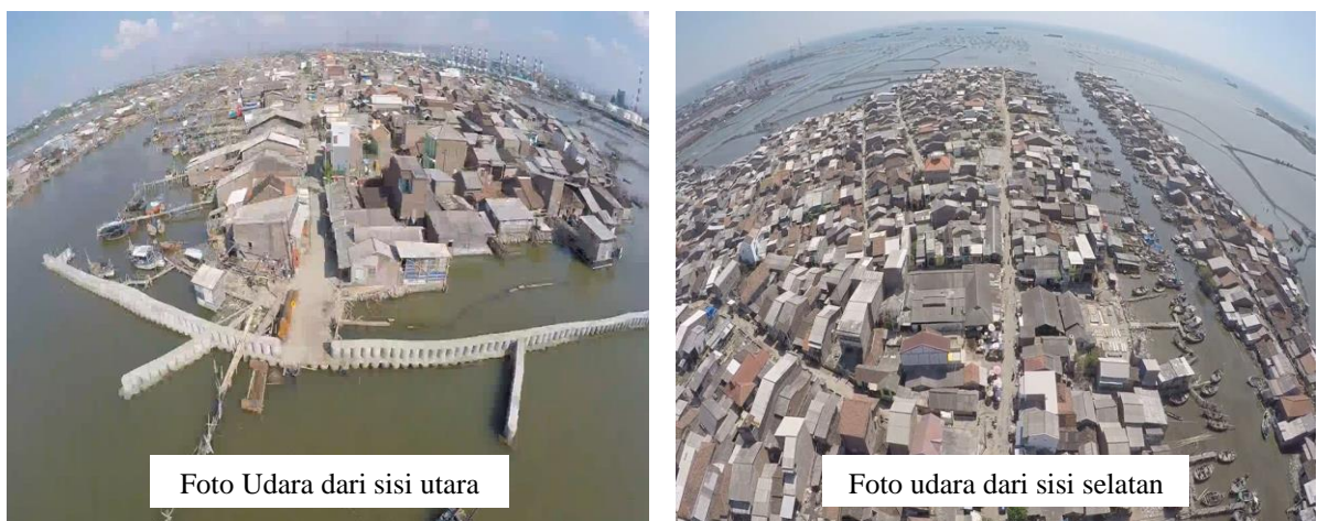
Gambar 4.13. Foto Udara Kali Banger mati sebelum dilakukan penataan
