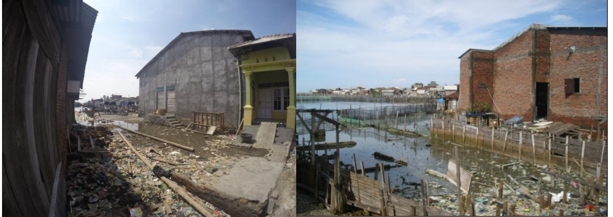
Gambar 4.4. Kondisi Persampahan Yang Tidak Tertangani
